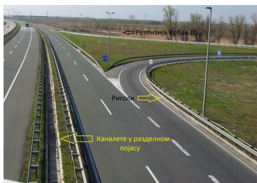
Слика 2. - Прикупљање воде са коловоза [4]
